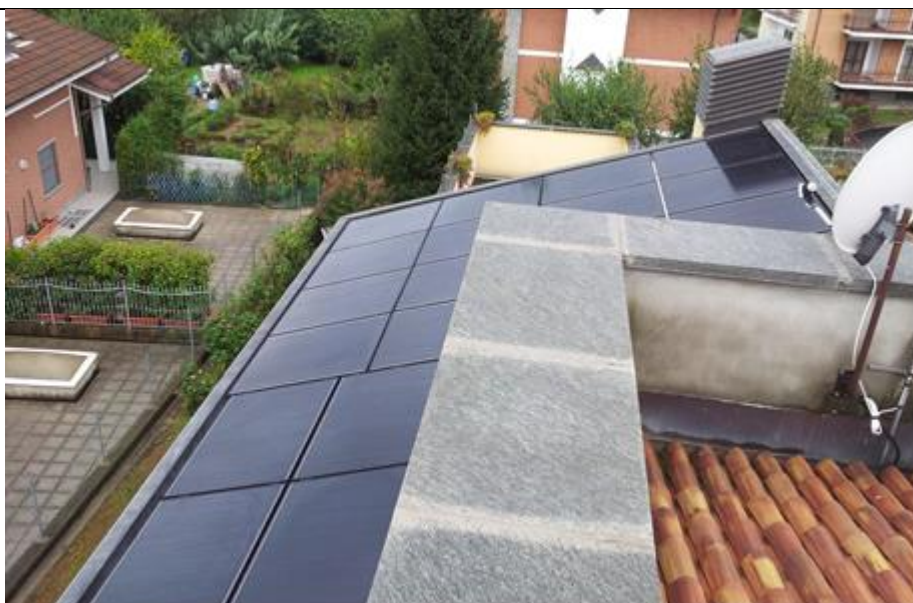
Impianto fv da 3,0 kWp, con tecnologia senza silicio, in rame-indio-selenio, realizzato nel 2014 a CUMIANA (TO)
