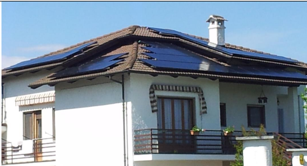
Impianto fv da 6,8 kWp, con tecnologia senza silicio, in rame-indio-selenio, realizzato nel 2014 a VIRLE PIEMONTE (TO)
