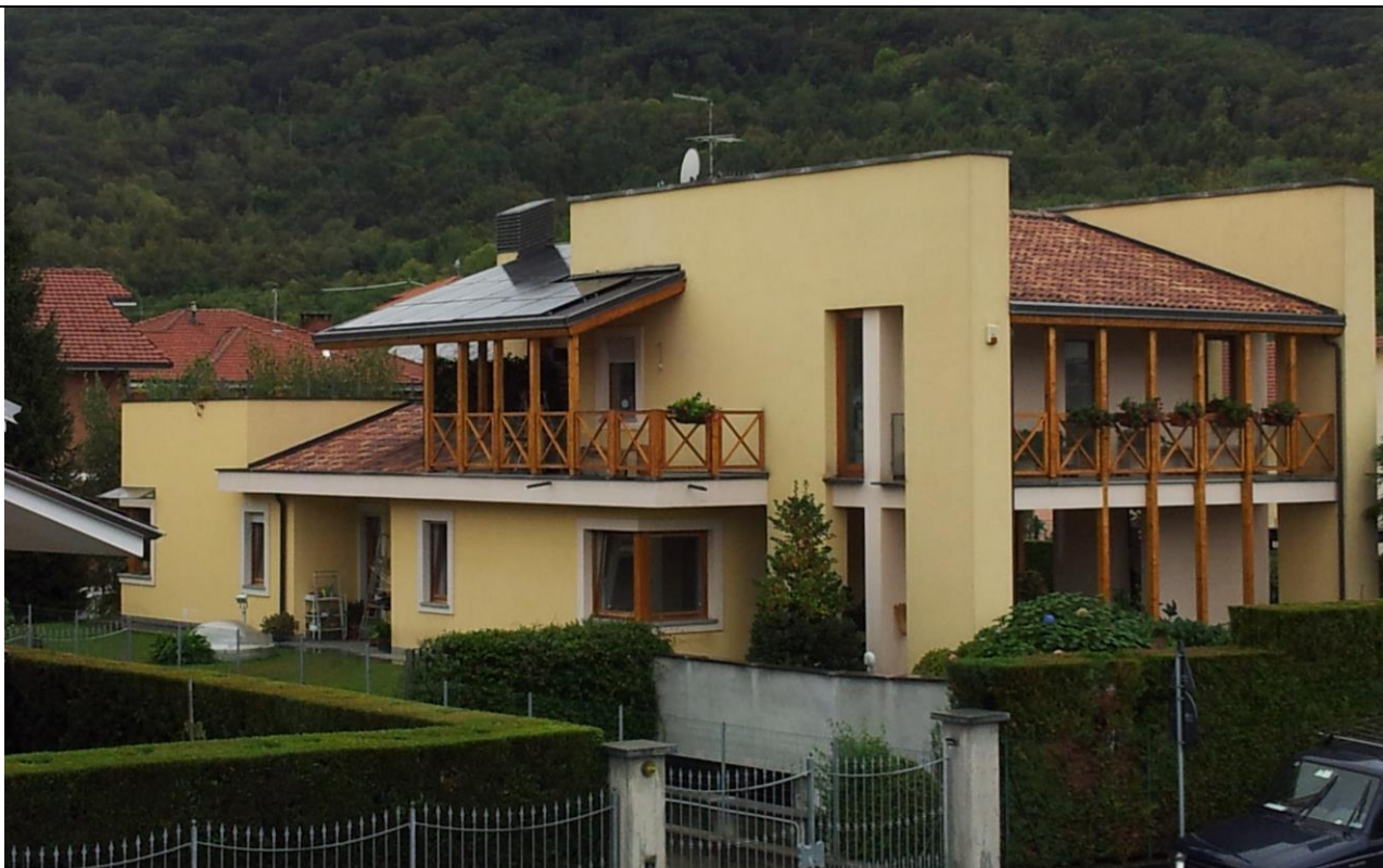
Impianto fv da 3,0 kWp, con tecnologia senza silicio, in rame-indio-selenio, realizzato nel 2014 a CUMIANA (TO)
